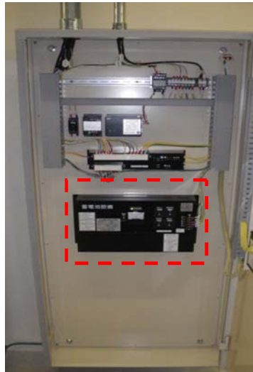
第4-1-31図 二酸化炭素自動消火設備（全域）制御盤内蓄電池
