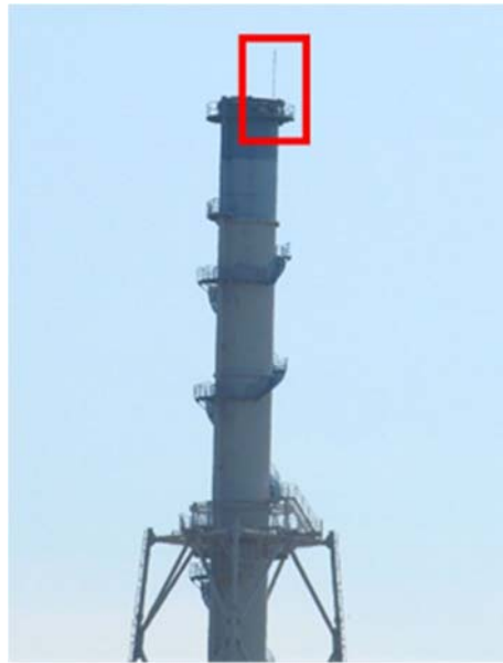
第41-1-16図 排気筒の避雷設備
