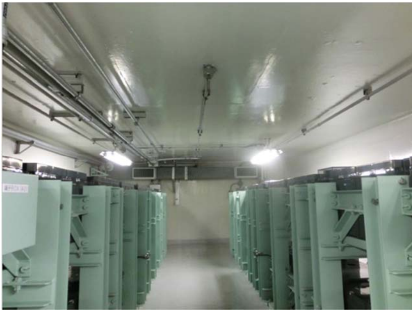
第41-1-41図 蓄電池の設置状況
