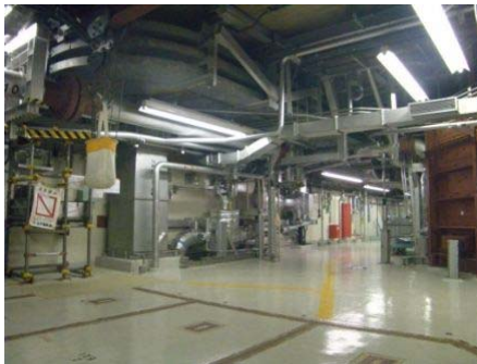
通路上の機器設置状況
