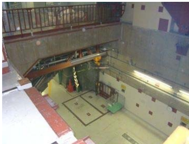
1階から2階機器ハッチ開口状況
