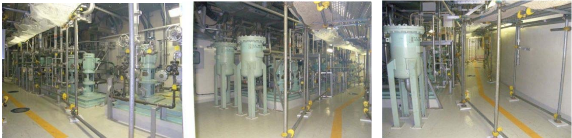
サンプポンプ設置状況
