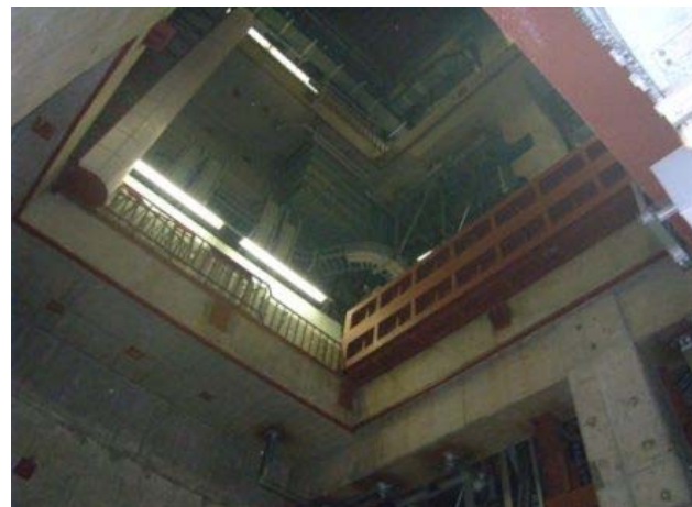
3階から4階機器ハッチ開口状況
