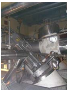
主蒸気隔離弁
