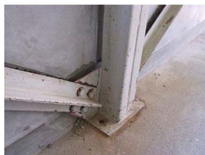
間柱脚部アンカーボルト破断
