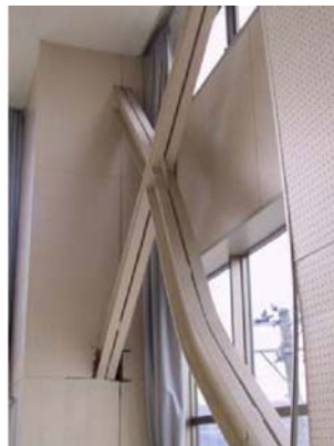
間柱脚部アンカーボルト破断
