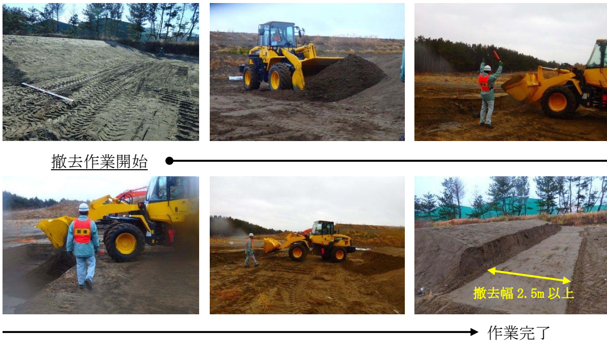
第 8 図 土砂撤去検証の写真
