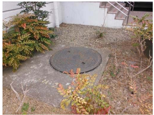
#49 マンホール蓋
