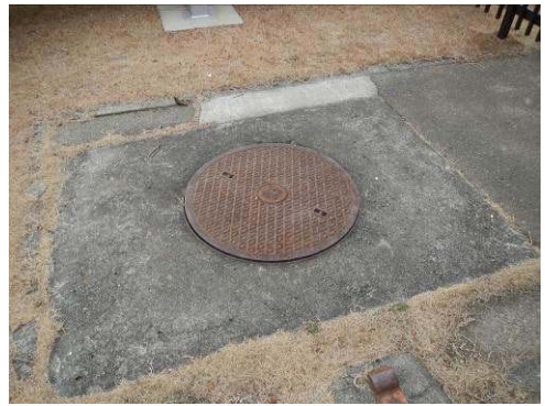
#246 マンホール蓋
