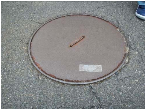
#316 マンホール蓋
