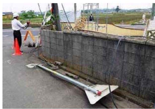
道路標識の倒壊
