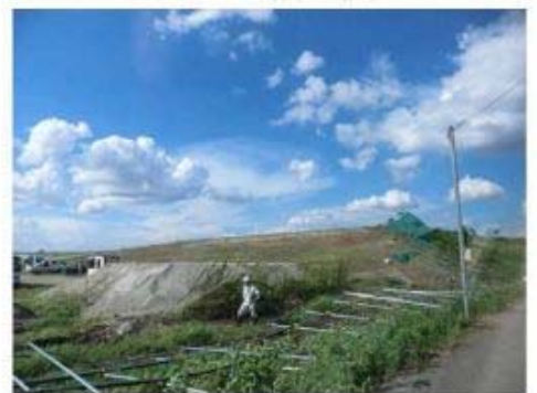
フェンスの倒壊
