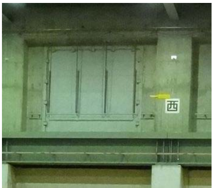
別図 1-32 東海第二発電所における原子炉建屋ブローアウトパネルの 設置状況
