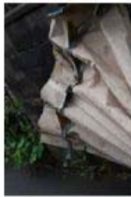
飛散した折板屋根の損傷状況
