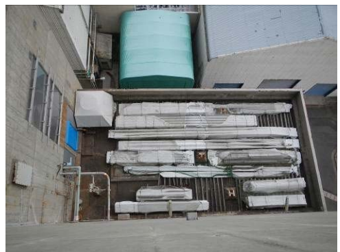
#301 足場板, 足場枠
