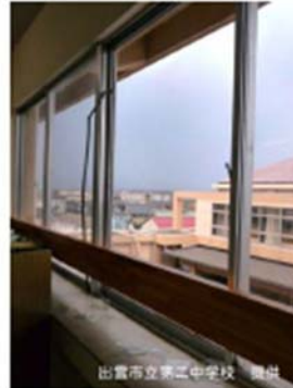
屋外に面した窓ガラス
