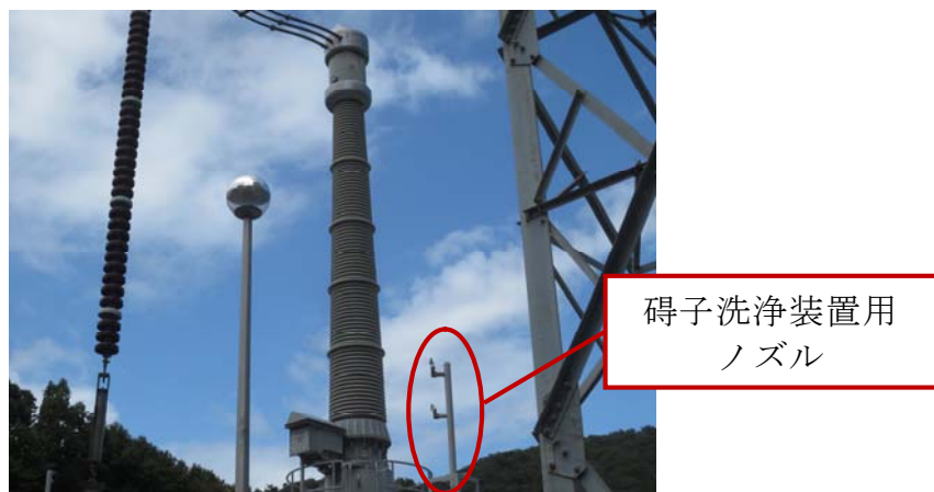
第 2.2.4.6-1 図 碍子洗浄装置外観（イメージ図）
