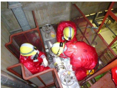
連絡配管閉止フランジ切替訓練
