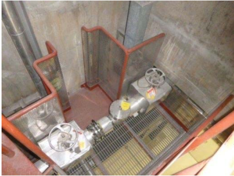
作業場所（全体）
