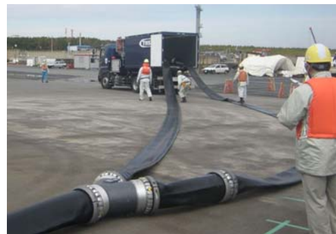
東海港での送水訓練 (ホース敷設)
