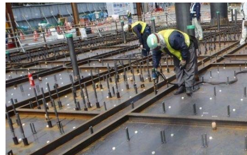
スタッドの施工状況
