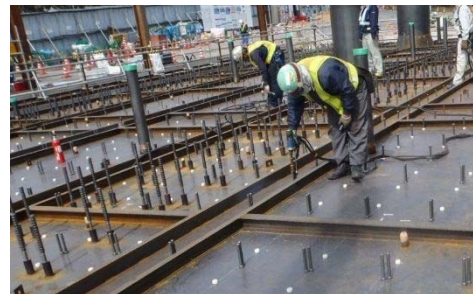
スタッドの施工状況
