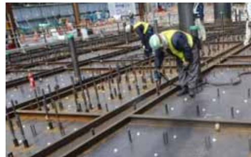
スタッドの施工状況
