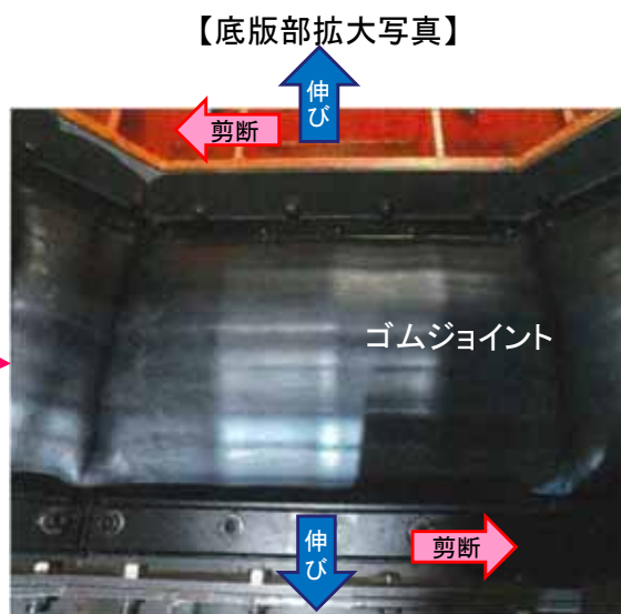
試験状況(伸び250mm加圧時)
