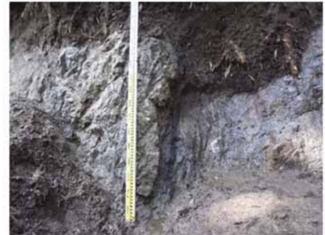
写真 断層部の全景
