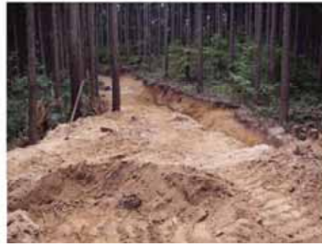
写真2 トレンチ全景(北東端から撮影)
