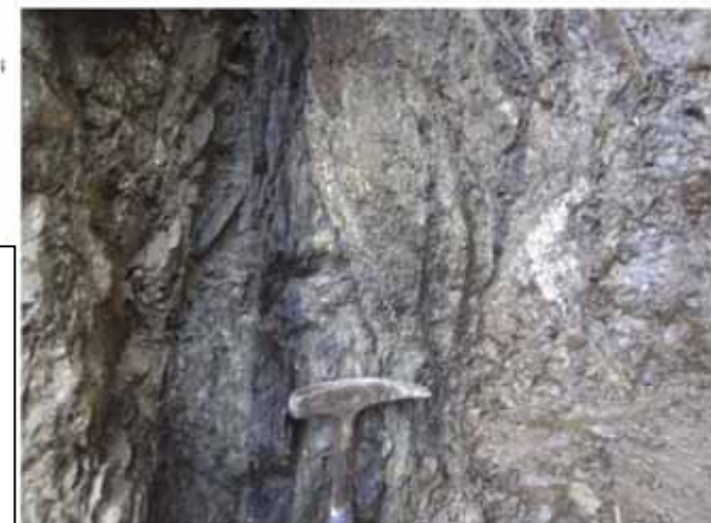
写真 断層部の拡大
