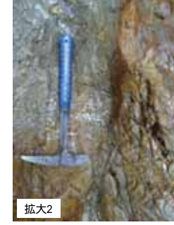
● 砂岩と泥岩の境界の断層面の連続性はやや不明瞭でしばしば分岐し、平面性は低い。また幅約5mmの砂礫岩を挟んでいるが、粘土状破砕部を伴わない。 ● 砂礫岩は、周囲の砂岩層と同様の固結の程度である。
