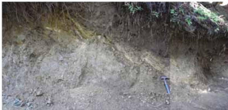
断層部の全景
