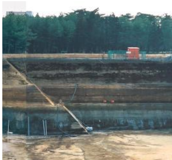
掘削工事時の法面写真（平成3年）
