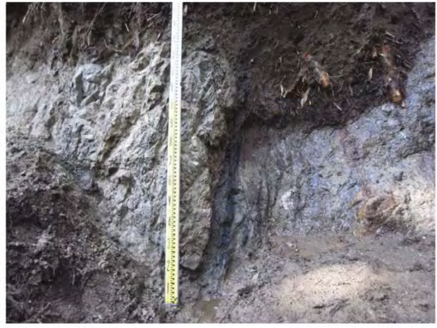
写真① 断層部の全景
