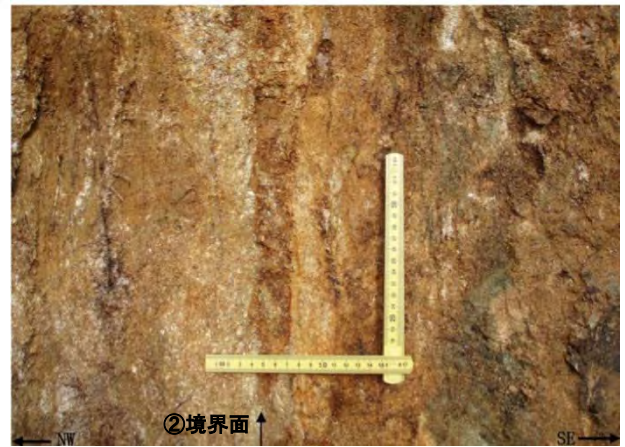
写真2 露頭拡大写真
