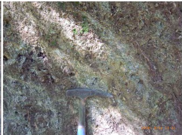
写真2 片状カタクレーサイトの状況
