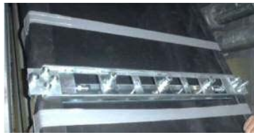
第 6-1-5 図 垂直設置方向トレイに対するファイアストップ施工例
