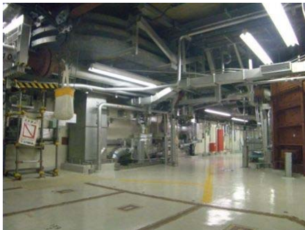
通路上の機器設置状況
