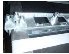
第 6-1-5 図 垂直設置方向トレイに対するファイアストップ施工例
