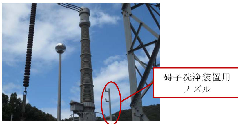
第2.2.4.6-1図 碍子洗浄装置外観（イメージ図）
