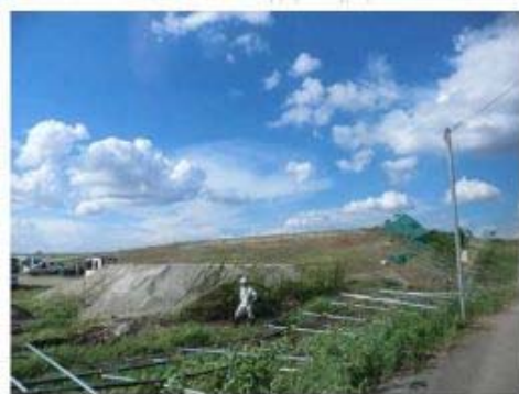
フェンスの倒壊
