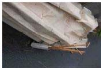
飛散した折板屋根の損傷状況
