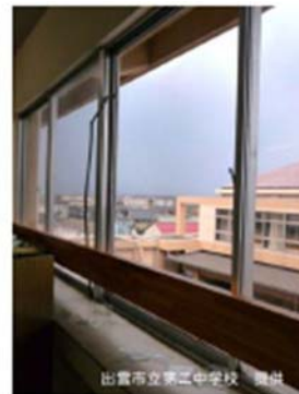
屋外に面した窓ガラス
