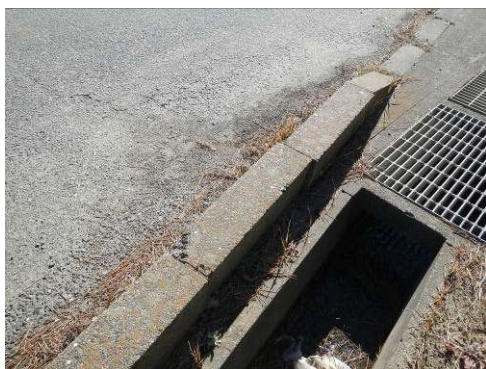
#417 コンクリート製ブロック
