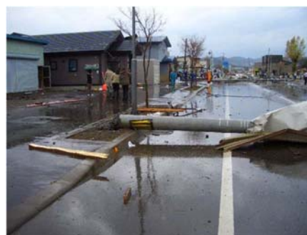
道路側へ倒壊した電柱
