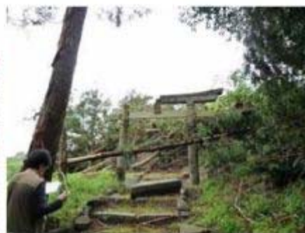
樹木の折損と鳥居の被害
