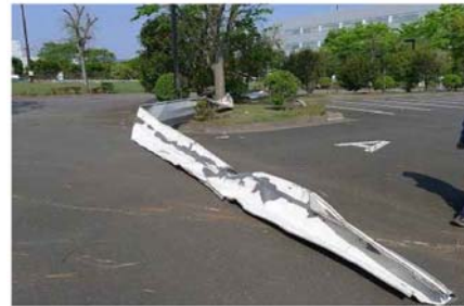
飛散した飛来物（鋼板製屋根材）
