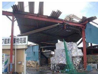
折板の損傷
