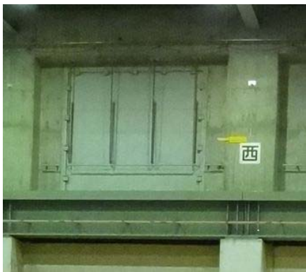
別図 1－32 発電所における原子炉建屋ブローアウトパネルの 設置状況
