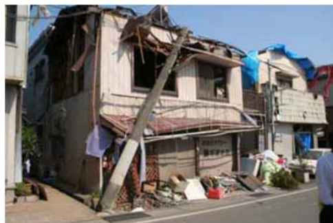
倒壊電柱に直撃された家屋
