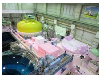
原子炉建屋原子炉棟 6階西側
