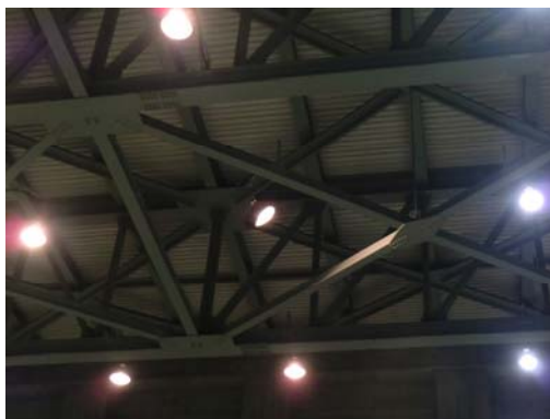
原子炉建屋原子炉棟（天井面）
