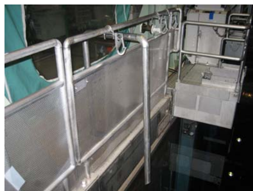
使用済燃料プール周り（手摺り）
