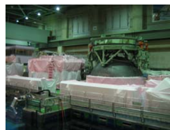
原子炉建屋原子炉棟 6階東側
