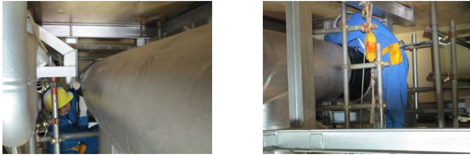
第2図 狭隘部作業状況
