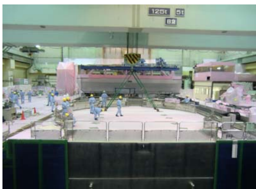
使用済燃料プール周り（全体）
