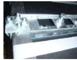
第 6-1-5 図 垂直設置方向トレイに対するファイアストップパ施工例
