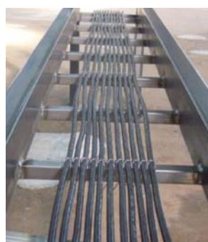
（シート施工前）
