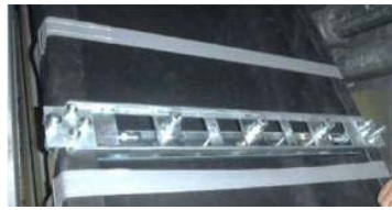
第 6-1-5 図 垂直設置方向トレイに対するファイアストップパ施工例
