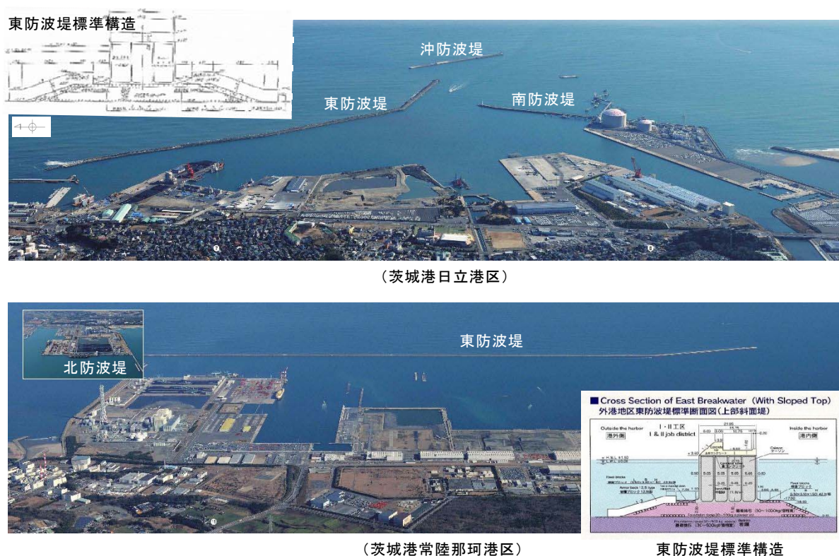
第1.2-5図 茨城港日立港区及び茨城港常陸那珂港区における防波堤整備状況（平成28年3月）
