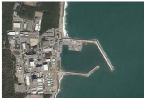
写真① 東海第二発電所全景
