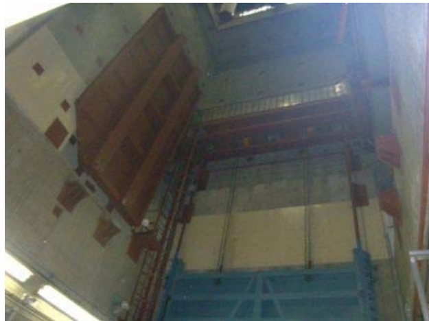
1階機器ハッチ開口状況
