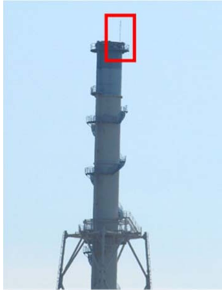
第41-1-16図 排気筒の避雷設備
