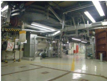
通路上の機器設置状況
