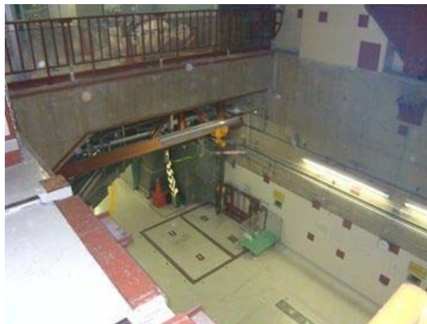
1階から2階機器ハッチ開口状況
