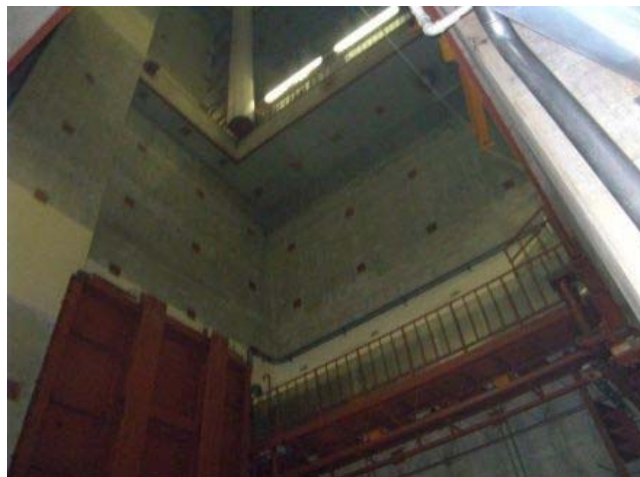
2階から3階機器ハッチ開口状況
