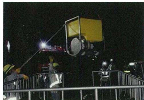
夜間での送水訓練（ポンプ設置）
