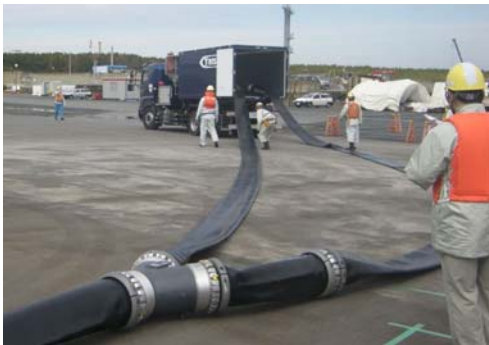
ホースの敷設状況
