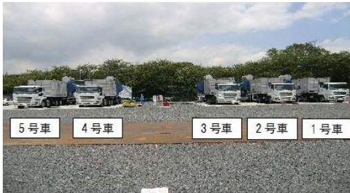
常設代替高圧電源装置（イメージ）
