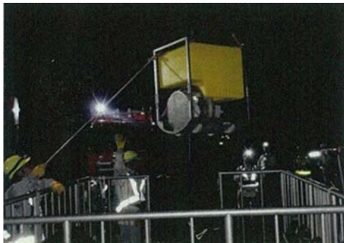
夜間での送水訓練（ポンプ設置）
