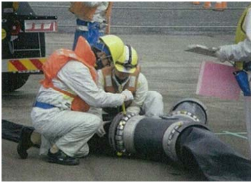
ホース接続訓練
