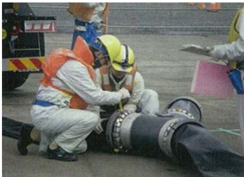
ホース接続訓練
