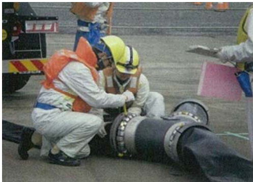
ホース接続訓練
