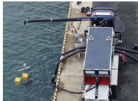
水中ポンプの設置状況
