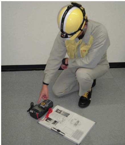
電池容量確認
