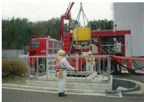
放射線防護具着用による送水訓練 （水中ポンプユニット設置）
