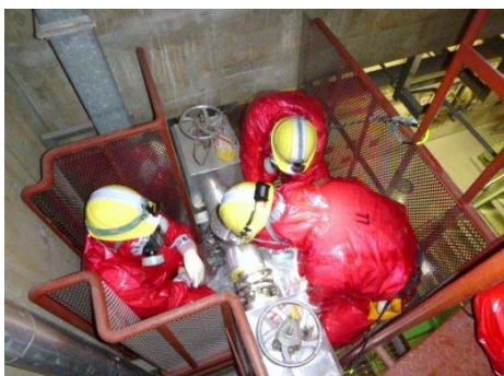
連絡配管閉止フランジ切替え訓練
