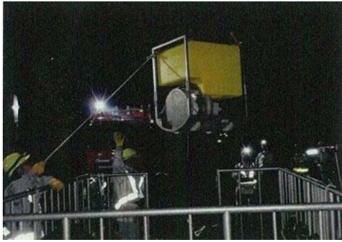
夜間での送水訓練（ポンプ設置）
