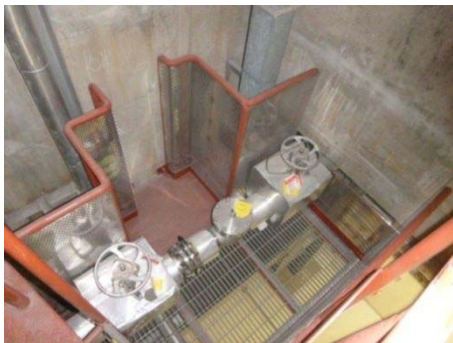
作業場所（全体）
