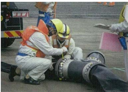
ホース接続訓練
