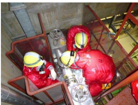
連絡配管閉止フランジ切替え訓練
