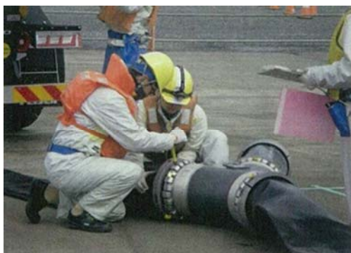
ホース接続訓練
