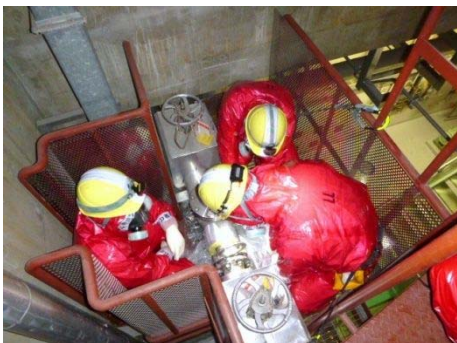
連絡配管閉止フランジ切替え訓練
