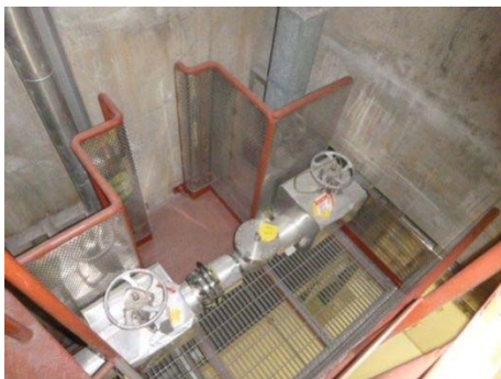
作業場所（全体）
