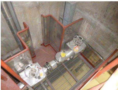
作業場所（全体）
