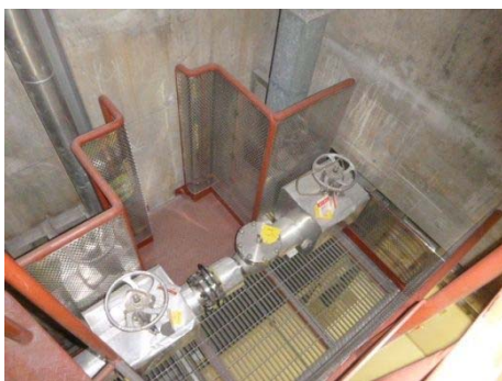
作業場所（全体）
