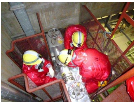
連絡配管閉止フランジ切替え訓練
