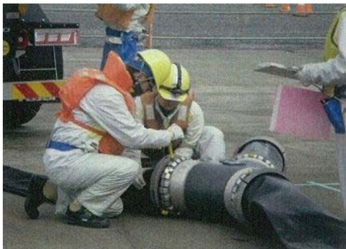
ホース接続訓練
