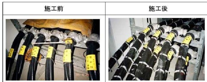
(2) 受け枕、ラック等へのケーブルの結束はケーブル敷設工事基準に従ってください。
