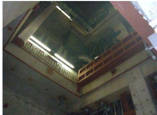
3階から4階機器ハッチ開口状況
