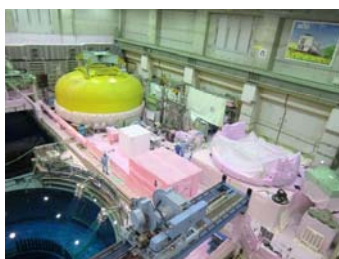
原子炉建屋原子炉棟 6 階西側
