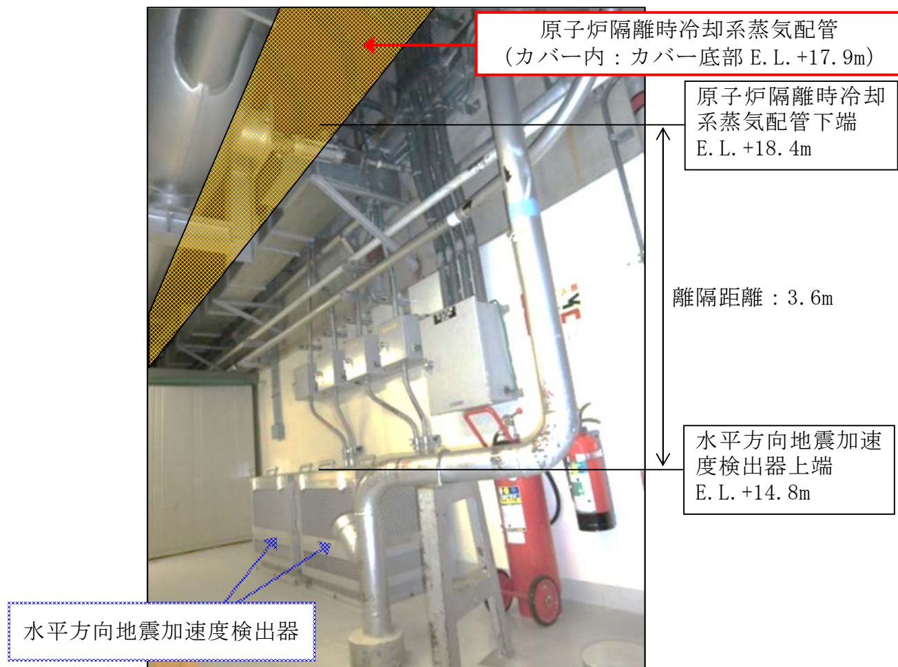
第3図 現場状況写真 原子炉棟 2階 (E.L.+14.0m)
