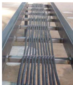
(シート施工前)
