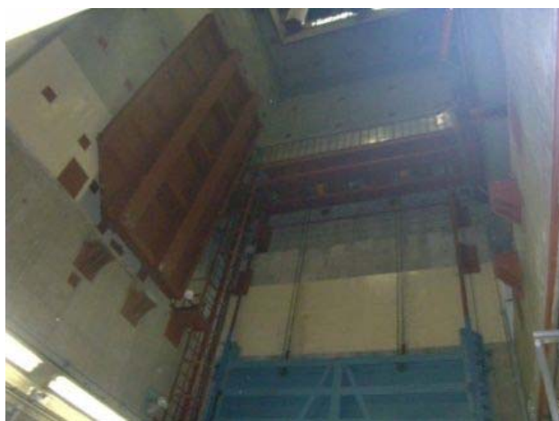
1階機器ハッチ開口状況
