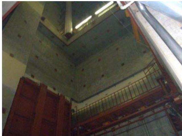
2階から3階機器ハッチ開口状況
