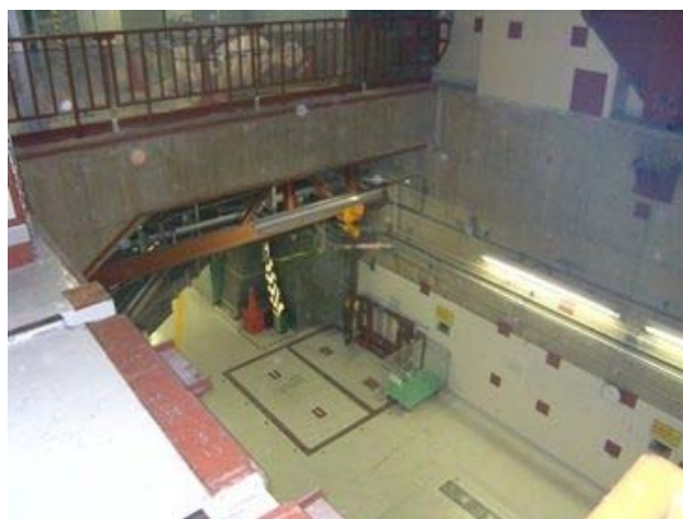
1階から2階機器ハッチ開口状況
