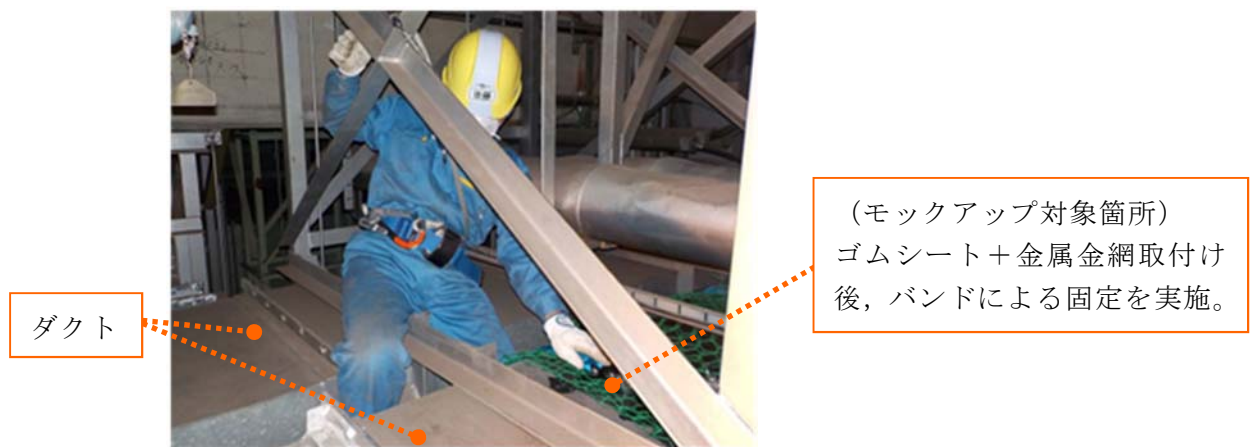
第5図 狹隘部作業状況
