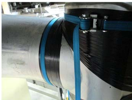
第3図 修復模擬作業状況
