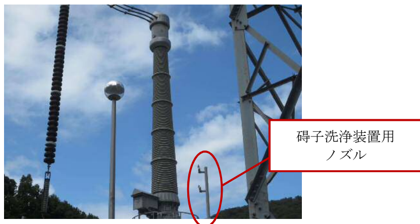
第 14 図 碍子洗浄装置外観（イメージ図）
