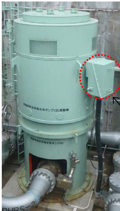
第2.4.2-6図 残留熱除去系海水ポンプ電動機 構造図
