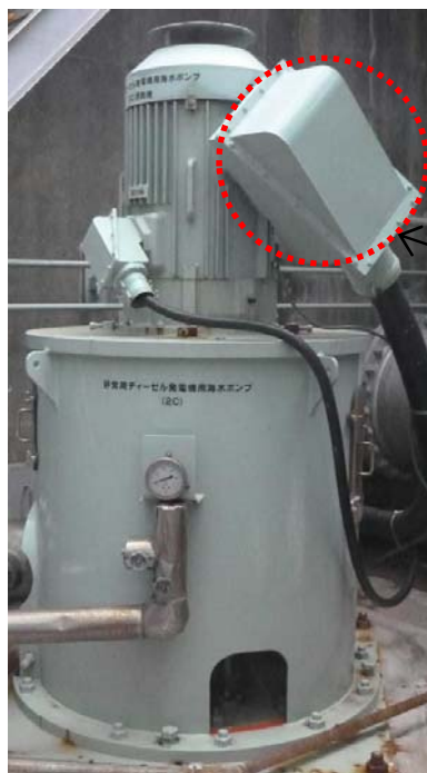
第 2.4.2-7 図 非常用ディーゼル発電機（高圧炉心スプレィ系ディーゼル発電機を含む。）用海水ポンプ電動機 構造図
