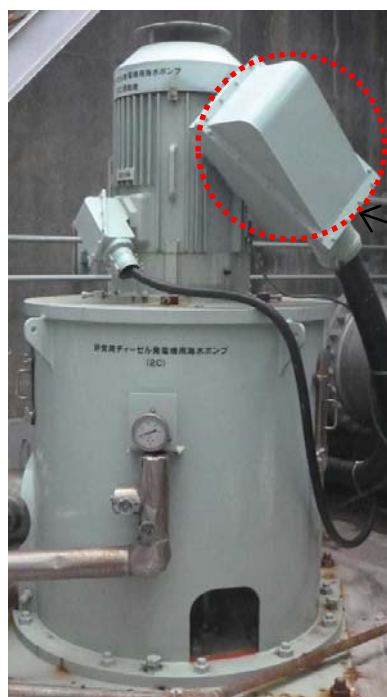
第 2.4.2-7 図 非常用ディーゼル発電機（高压炉心スプレイ系ディーゼル発電機を含む。）用海水ポンプ電動機 構造図
