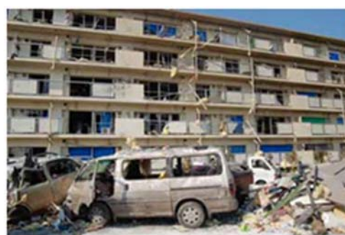
飛来物により被害を受けた住宅等
