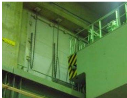
別図 1－32 発電所における原子炉建屋原子炉棟ブローアウトパネルの 設置状況
