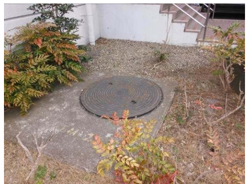
#49 マンホール蓋
