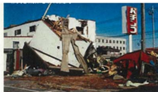
吹き飛ばされた建物
