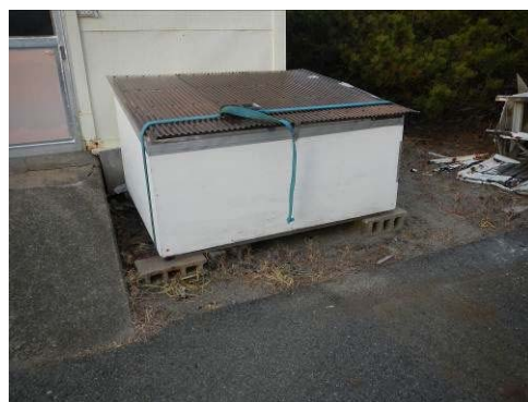
#350 鋼製ボックス
