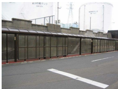
別図 1-12 発電所における屋外屋根の状況
