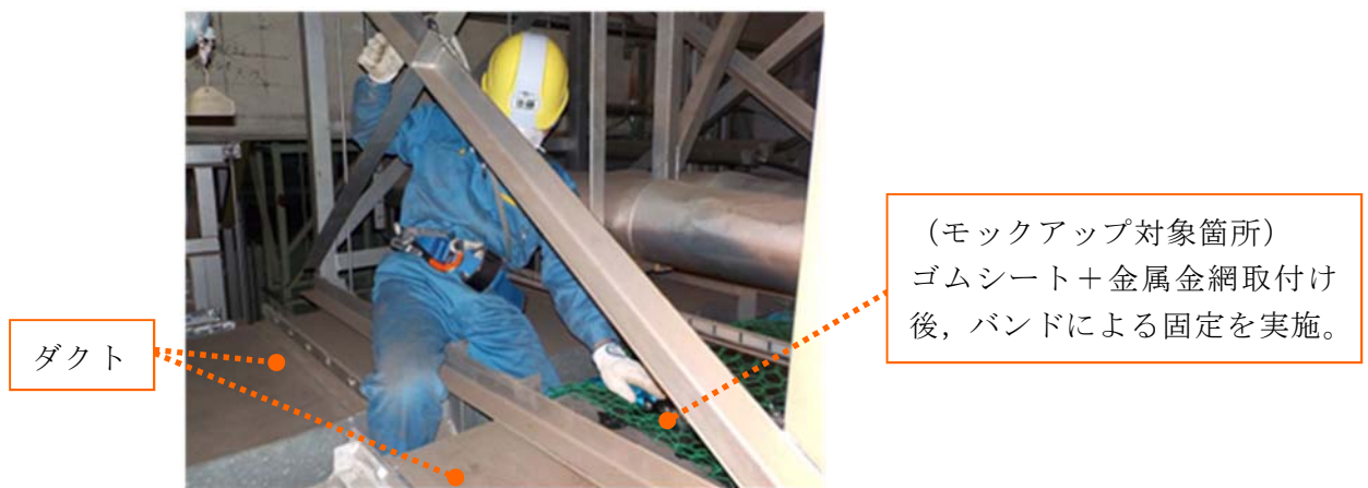
第5図 狭隘部作業状況
