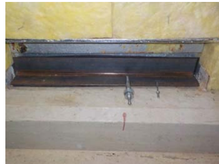
第7図 床貫通部模擬作業状況
