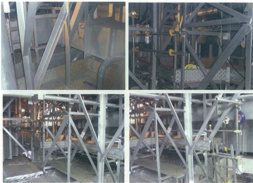
第4図 現場モックアップ状況（足場組立全景）
