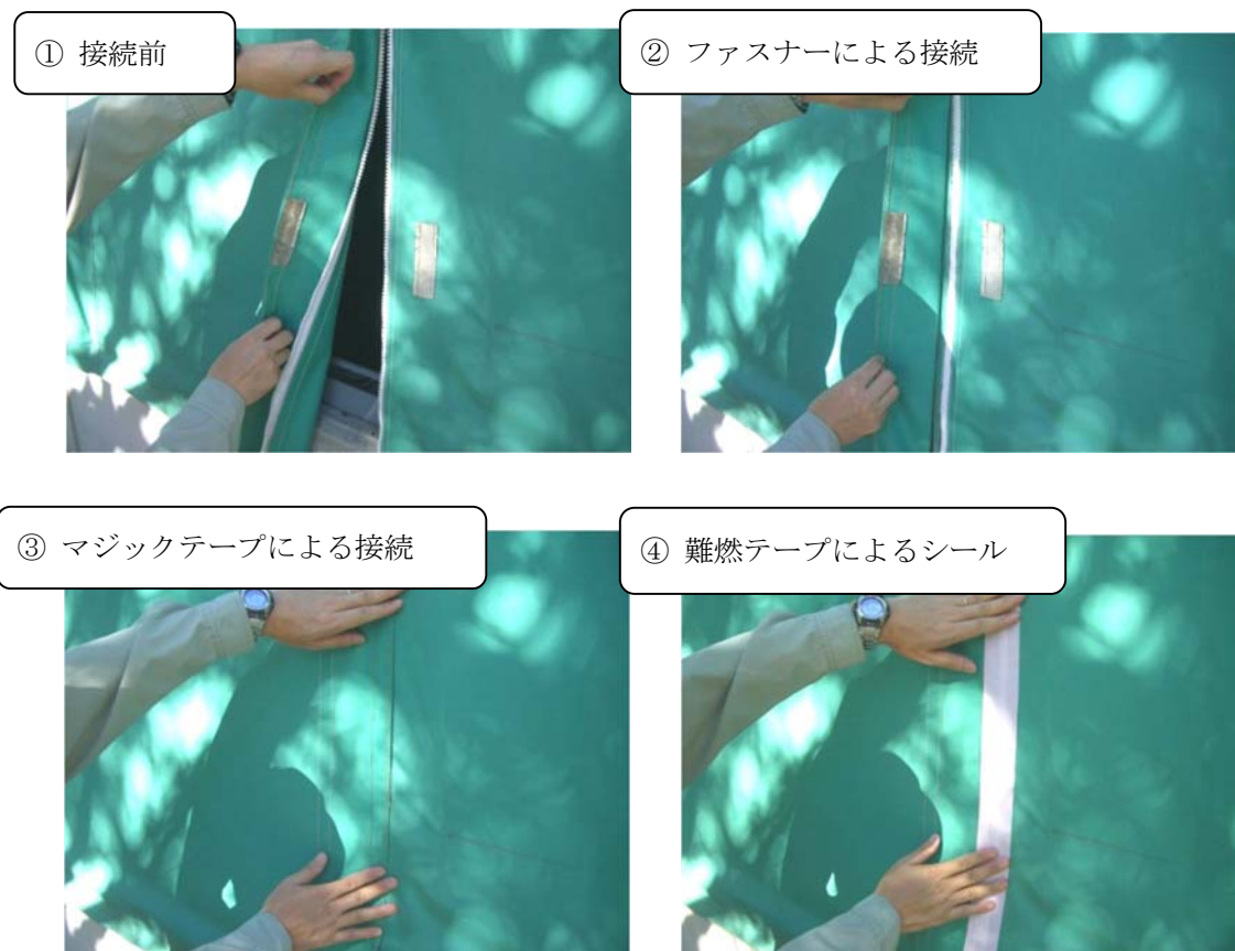
図 1-1-9 各テントハウス間の接続（イメージ）
