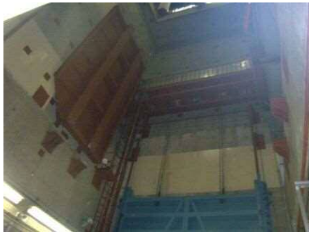
1階機器ハッチ開口状況
