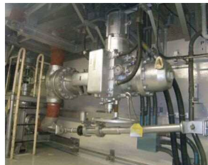
電動弁及び電線管他
