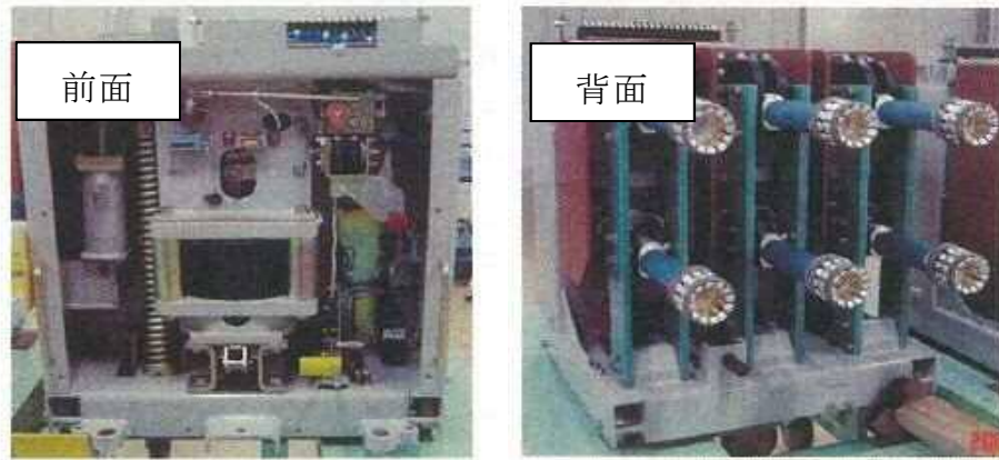
第41-1-13図 真空遮断器外観
