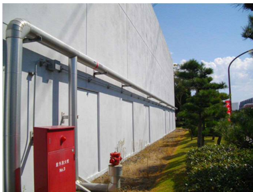
第41-1-36図 屋外消火配管への保温材設置状況
