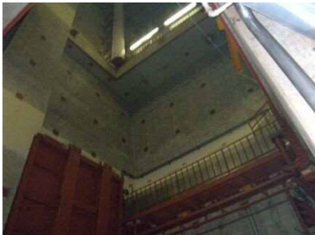
2階から3階機器ハッチ開口状況
