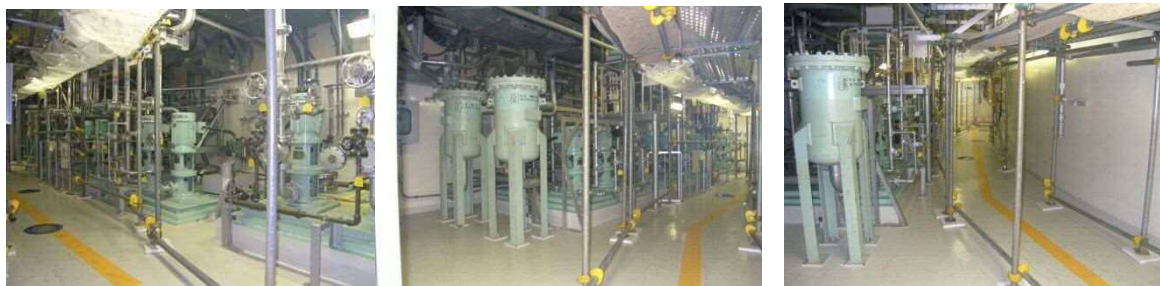
サンプポンプ設置状況
