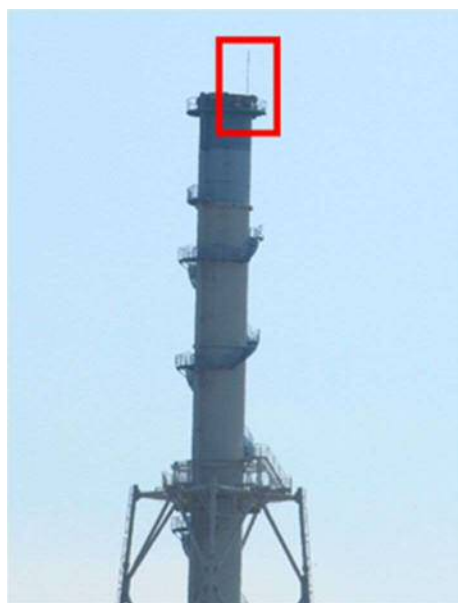
第41-1-16図 排気筒の避雷設備
