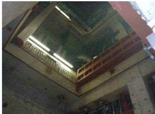
3階から4階機器ハッチ開口状況
