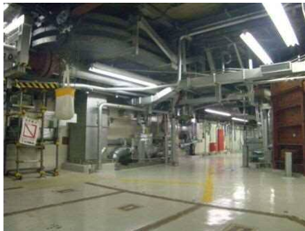
通路上の機器設置状況
