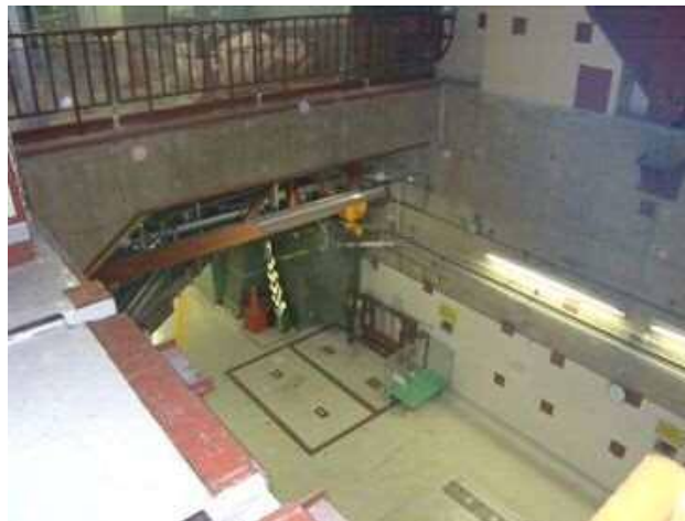
1階から2階機器ハッチ開口状況
