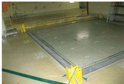
支柱レールの取付状況
