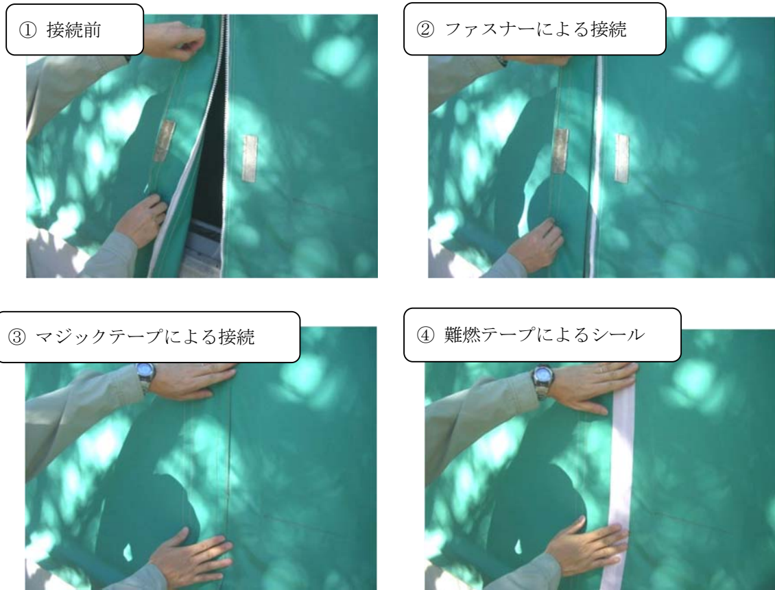
図 1-9 各テントハウス間の接続 (イメージ)
