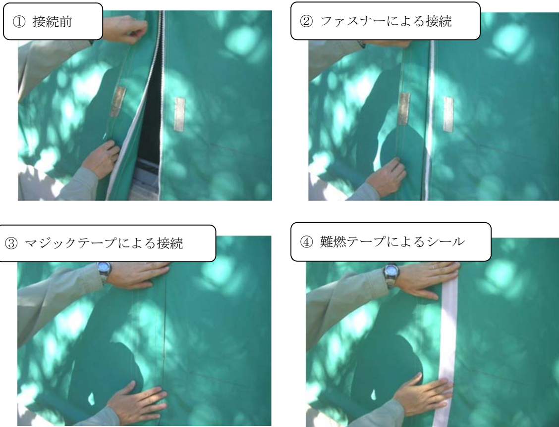
図 1-9 各テントハウス間の接続 (イメージ)
