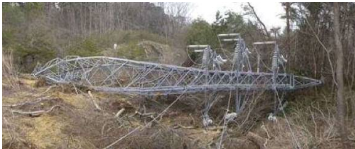
地震による斜面の崩落に伴う送電鉄塔の倒壊事例※ 2
