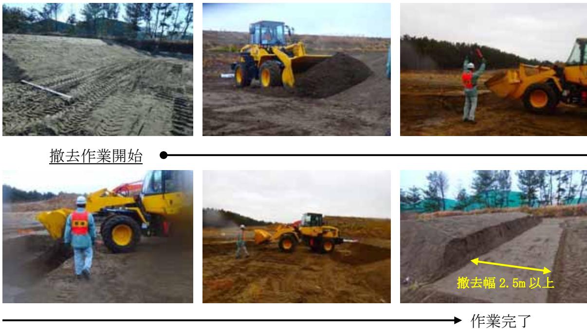
第 8 図 土砂撤去検証の写真
