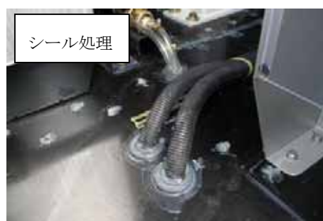
第1図 可搬型設備 小動物対策例 (1/2)
