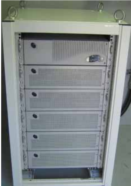
無停電電源装置
