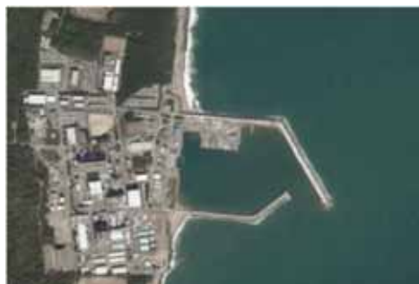
写真① 東海第二発電所全景
