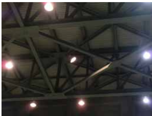
原子炉建屋原子炉棟（天井面）
