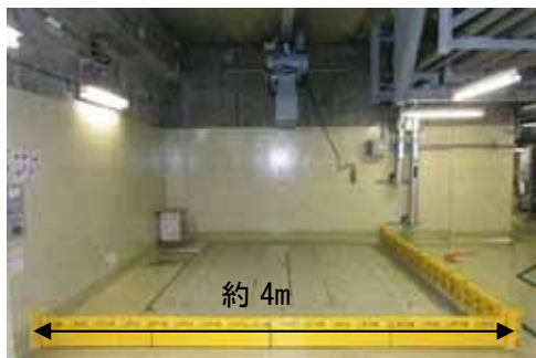
堰設置状況 約4m
