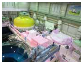
原子炉建屋原子炉棟 6階西側
