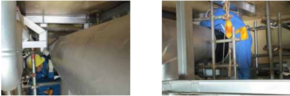
第2図 狭隘部作業状況
