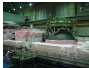
原子炉建屋原子炉棟 6階東側
