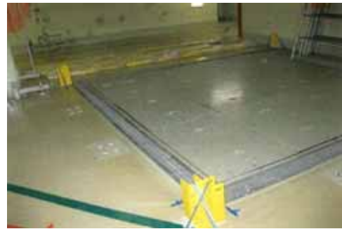
支柱レールの取付状況
