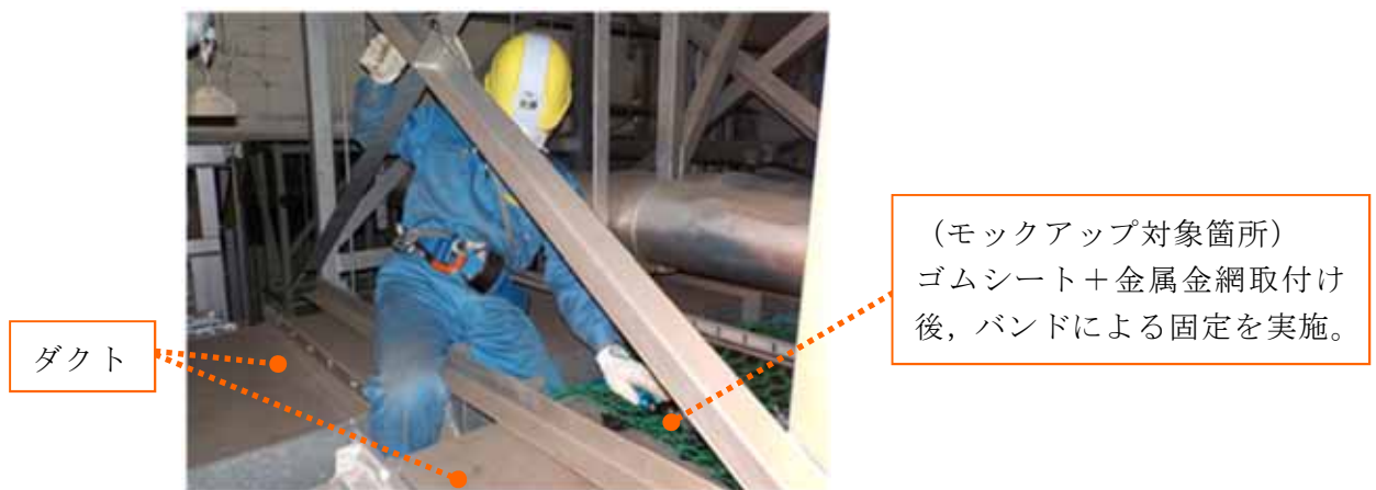
第5図 狭隘部作業状況
