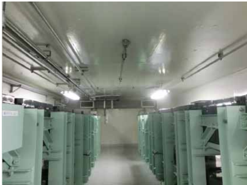
第 1-43 図 蓄電池の設置状況
