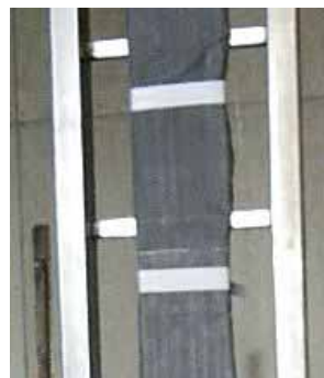
(シート施工後)
