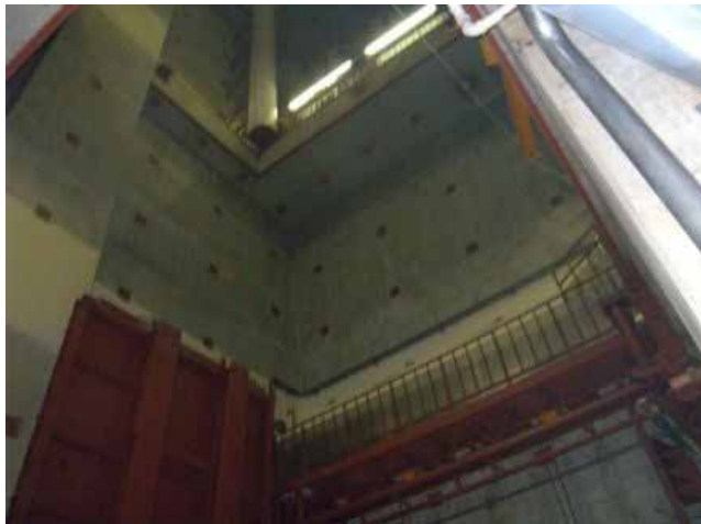
2階から3階機器ハッチ開口状況
