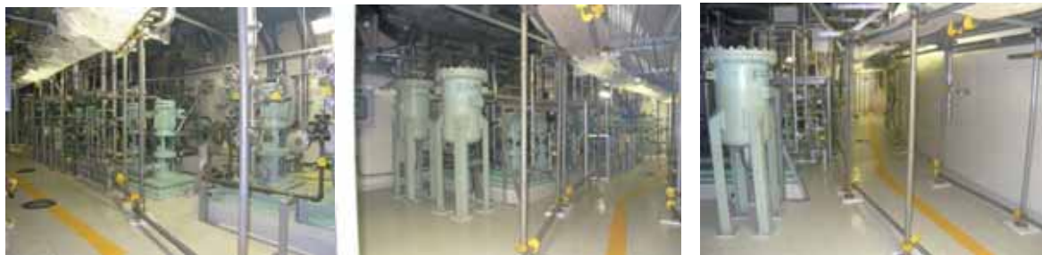
サンプポンプ設置状況
