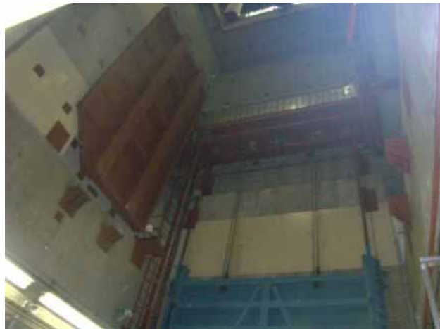
1階機器ハッチ開口状況
