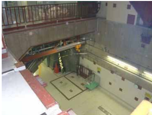
1階から2階機器ハッチ開口状況
