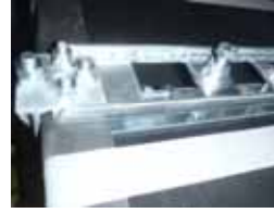
第 7-1-5 図 垂直設置方向トレイに対するファイアストップ施工例
