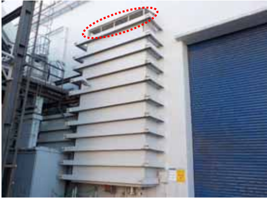
第2図 ディーゼル駆動消火ポンプ室給気口
