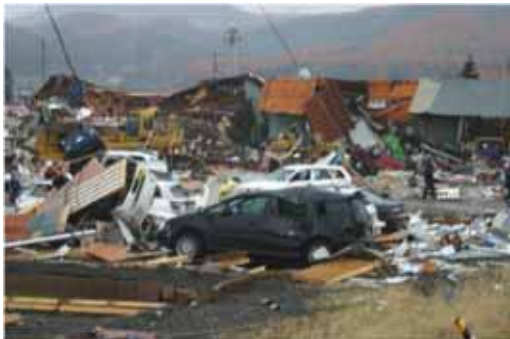
全壊した工事事務所周辺
