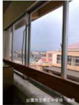
屋外に面した窓ガラス
