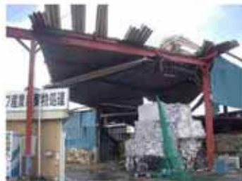
折板の損傷
