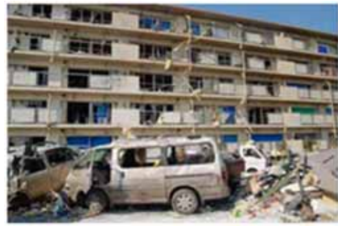
飛来物により被害を受けた住宅等
