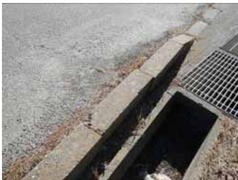
#417 コンクリート製ブロック
