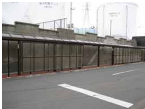
別図 1-12 発電所における屋外屋根の状況
