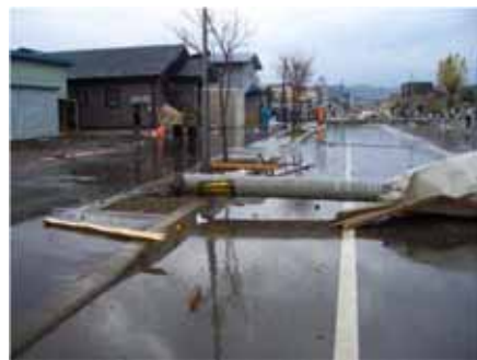
道路側へ倒壊した電柱
