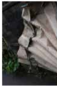
飛散した折板屋根の損傷状況
