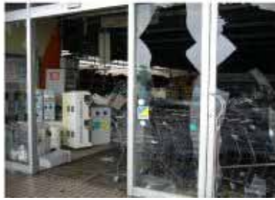
エントランスの窓ガラスの損壊
