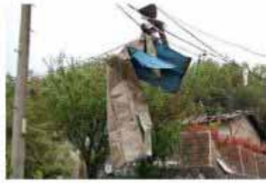
電線等に引っ掛かった飛来物（鋼板製屋根材）
