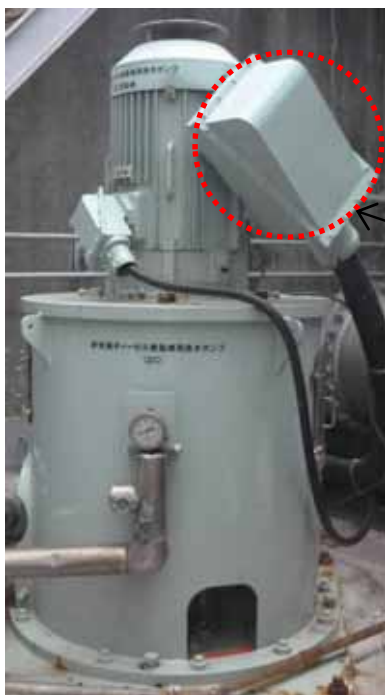
第2.4.2-7図 非常用ディーゼル発電機（高压炉心スプレィ系ディーゼル発電機を含む。）用海水ポンプ電動機 構造図
