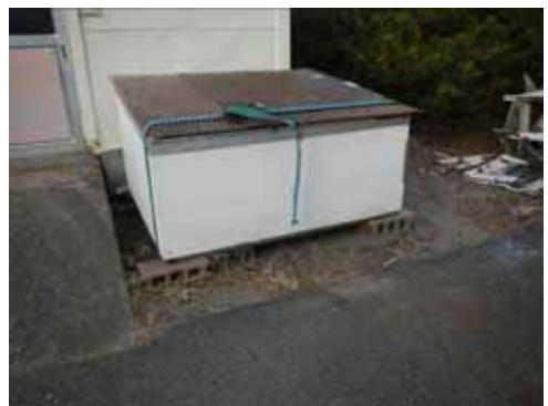
#350 鋼製ボックス
