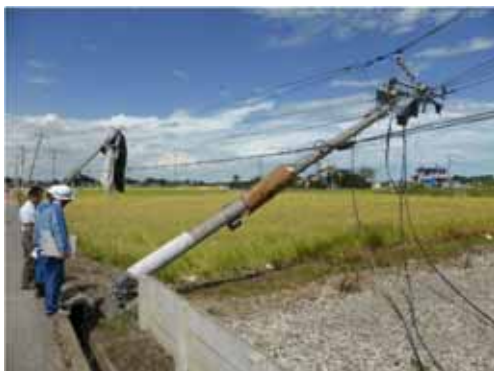
電柱の倒壊
