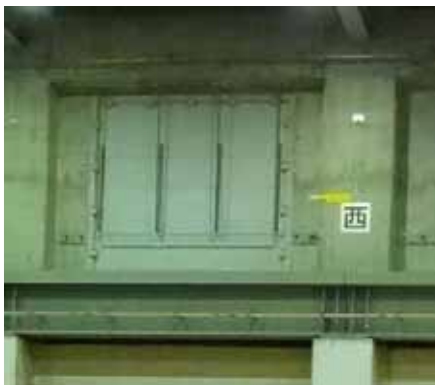
別図 1-32 発電所における原子炉建屋原子炉棟ブローアウトパネルの 設置状況
