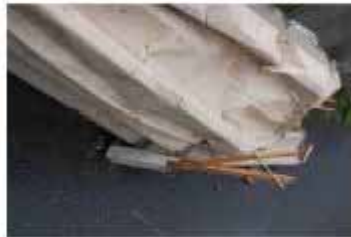
飛散した折板屋根の損傷状況
