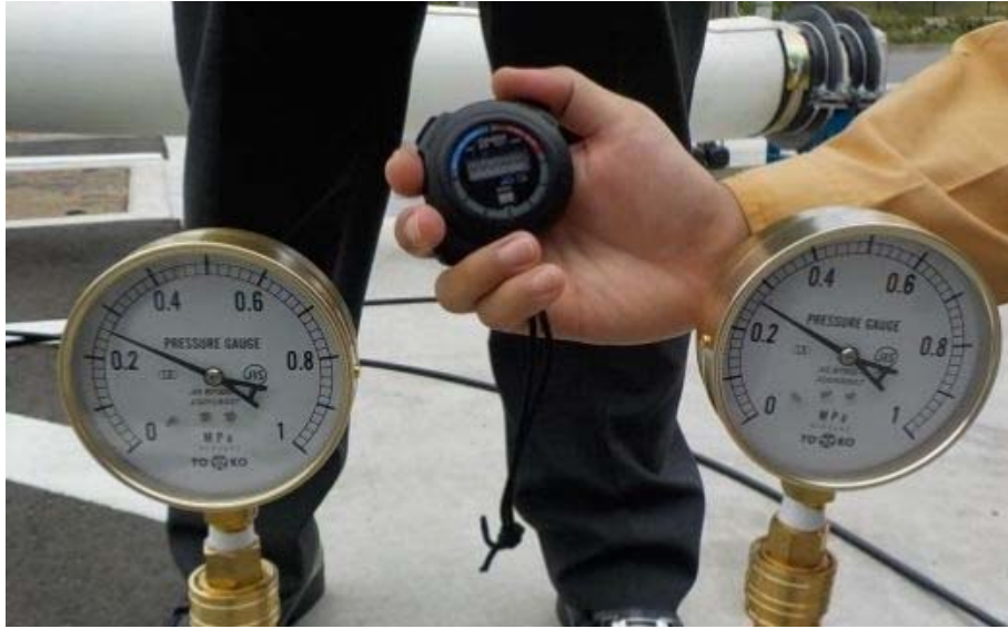
(c) 試験状況写真
