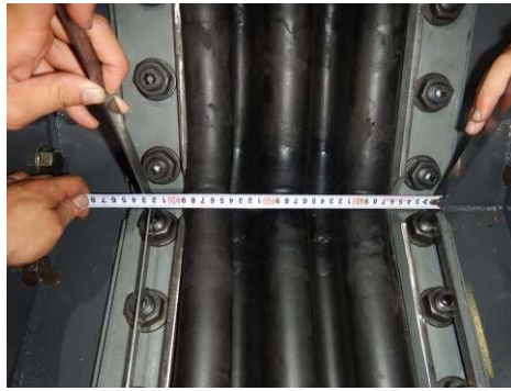
ボルトピッチ計測状況
