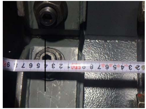
第 5.14.1.2-11 図 ゴムジョイント設置時 枠-ボルト間計測
