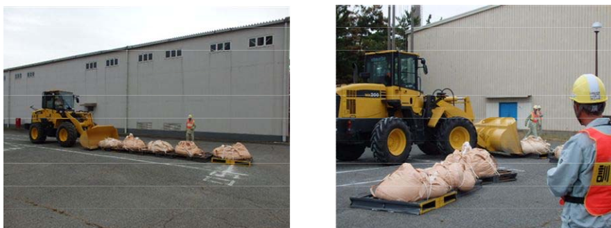
第 8-4 図 がれき撤去検証の写真
