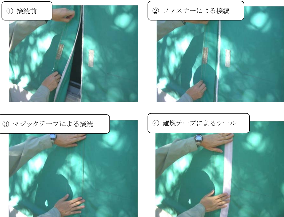
図 1-9 各テントハウス間の接続（イメージ）
